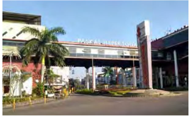
PINTU MASUK KAWASAN Area Entrance
